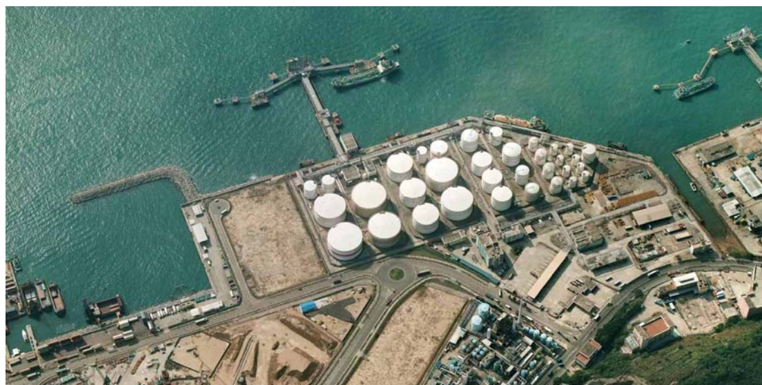
圖 G-1 石油氣儲存庫
