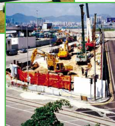
位於西九龍及上環的兩個專用石油氣加氣站興建中的情況
