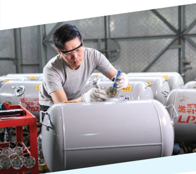
石油氣燃料缸工場
