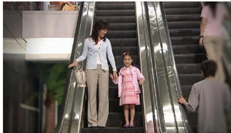
出乎意料，升降機及自動梯的設計很簡單，兩者都是根據滑輪原理操作。升降機利用升降對重裝置的金屬廂運行\*；自動梯則是通過類似輸送帶原理轉動梯級\*\*。從機械層面上，兩者的運作原理雖然簡單，但它們的效能卻遠遠超過其簡單的設計。
