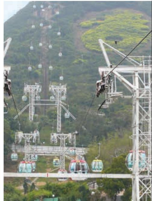
廂重量及提供暢順導向，有如火車軌般。平衡裝置於導軌纜下的是「牽引纜」，牽引纜由驅動系統推動，作用是通過可拆除式夾扣，牽引車廂沿導軌纜運行。
