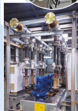
製冷機組的預製組件及利用建築信息模擬設計的模型
