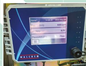
裝設於民航總總部的淡水冷卻塔水質監察系統
