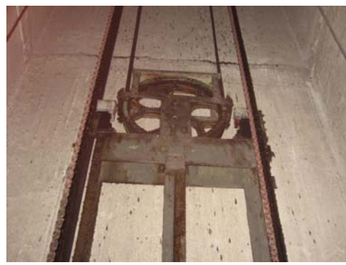
圖 4 - 升降機對重裝置沒有發現損壞。
