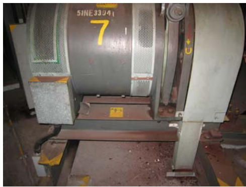
圖 3 - 機房內升降機發動機沒有發現損壞。
