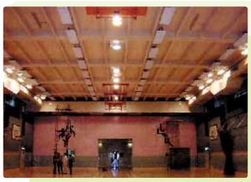
一個高輸出的T5燈照明系統現已於東啟德室內運動場應用(見右圖), 與現有使用高強度放電燈的高位照明系統比較,初步結果顯示可節能 超過四成(見上圖)。
