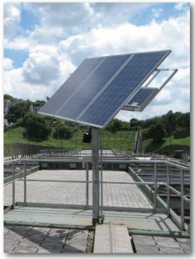
Figure 5: Sun tracking PV system at a Government venue 圖五:在政府場所內安裝的配備太陽追蹤器的光伏系統
