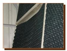
Deformed drift eliminator 已變形的收水器
