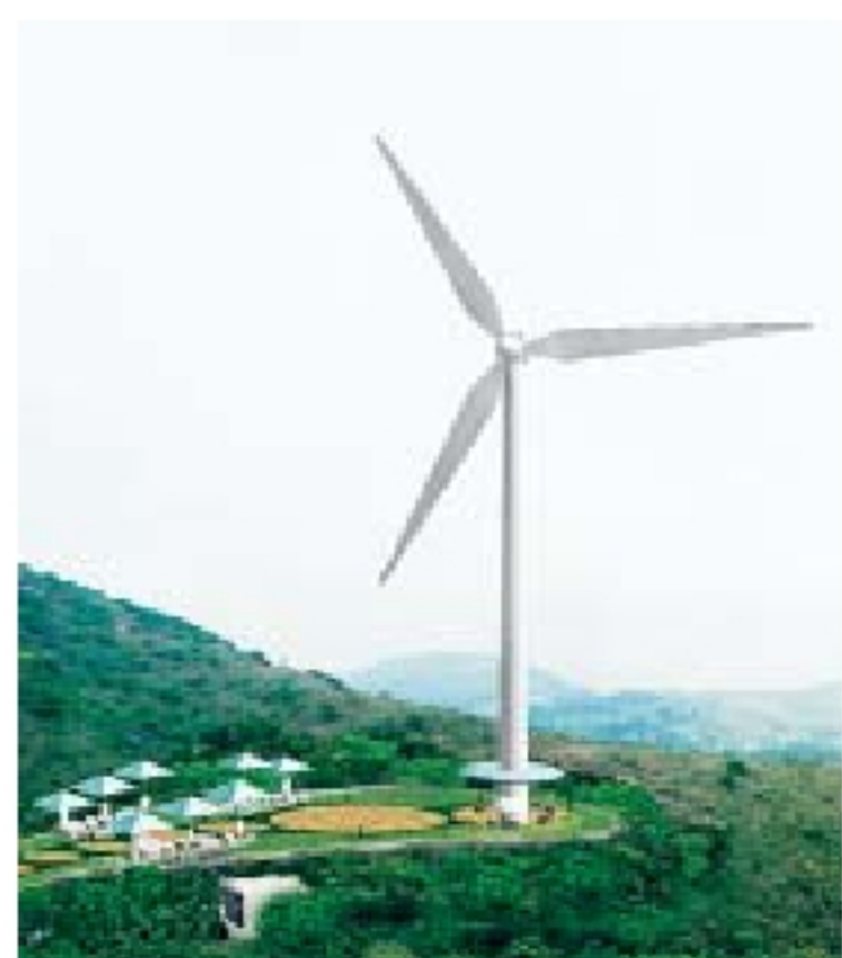
港燈南丫島風力發電站及構思中的環保資訊設施。
