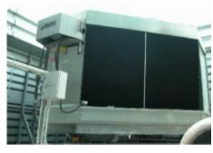
具有可變速驅動器 (VSD)的冷凍 機壓縮裝置由於價格持續下調, 考慮用以取代傳統的冷凍機。這類 裝置令壓縮器在局部負載的情況下 以低速度運行,其所產生的壓縮 (以千瓦/噸計算),較在局部 負載情況下用進氣導流片 (inlet guide vane)控制的離心冷凍機 為低。
