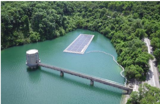
石壁水塘浮動太陽能發電系統
