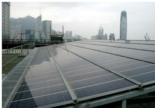
圖 2-2: 支架式光伏系統
