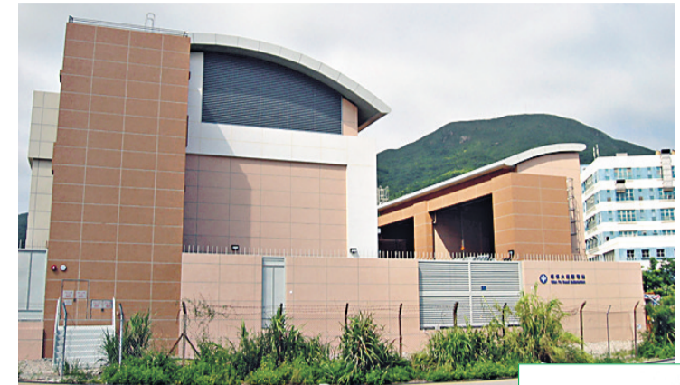
位於將軍澳環保大道變電站旁的儲蓄設備大樓上蓋進行，預計在 2008 年初完成後，將會成為本港首個「空中樹林」。它不但可吸取街上的污染物，改善空氣及水質；亦可降低室溫；更有助保護建築物的組織及結構，減省長期的維修保養成本。
