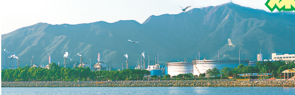
▲煤氣公司同時採用天然氣和石腦油來生產煤氣，為客戶提供安全、可靠、具成本效益及環保的燃料。
