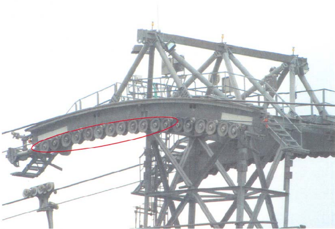
圖 6— 2B 號塔上共有 13 個滑輪損壞
