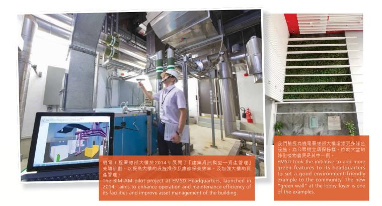
建築資訊模型技術在建造業已十分流行,特點是以智能的數據模型去改善建築物設計和數據存檔。去年機電工程署總部大樓進行了一個有關建築資訊模型技術的先導計劃,透過產業管理系統與建築資訊模型融合,從而有效地與現有的樓運系統及新設計和安裝的電子系統,如射頻路電視、實時定位系統相配合,應用在流動裝置上。結果顯示這技術有助改善操作及維修、本,更有助工程資產管理。我們已陸續與客戶分享經驗,協助他們的建築項目採用這個新技術。
