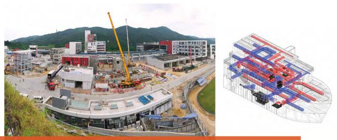
我們為消防處將軍澳消防訓練學校繼續建造第二期項目的多個實景模型,協助提升模擬消防訓練的質素。(右)採用建築資訊模型技術設計的模擬船隻事故訓練設施。
