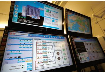
為達致更佳的能源管理,我們為公共衞生檢測中心更換了更高效能的製冷機並為大樓內的機電設備進行數碼轉型工作,以便傳輸數據進行分析。
