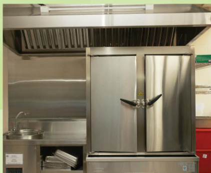
機電工程署的環保午膳隊為學校提供全面服務，包括為綠色廚房安裝蒸飯機。
