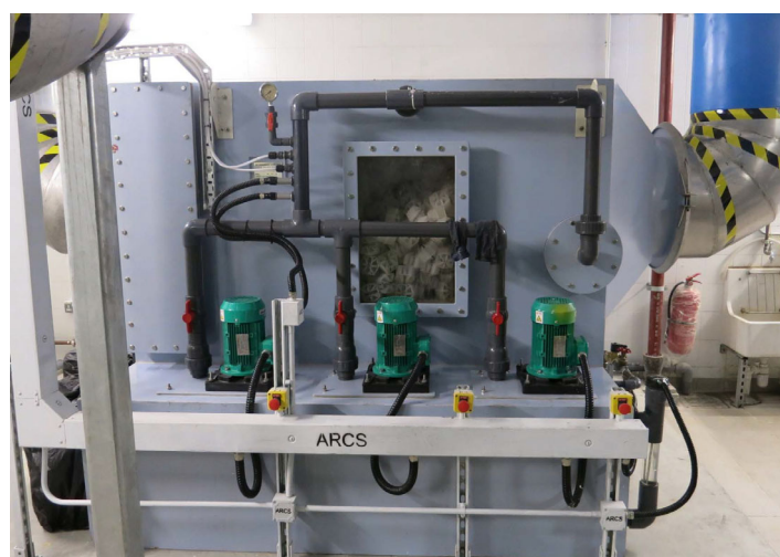
Figure 6.7 (d) : Venturi scrubber
