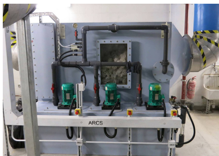
Figure 6.7 (d) : Venturi scrubber
