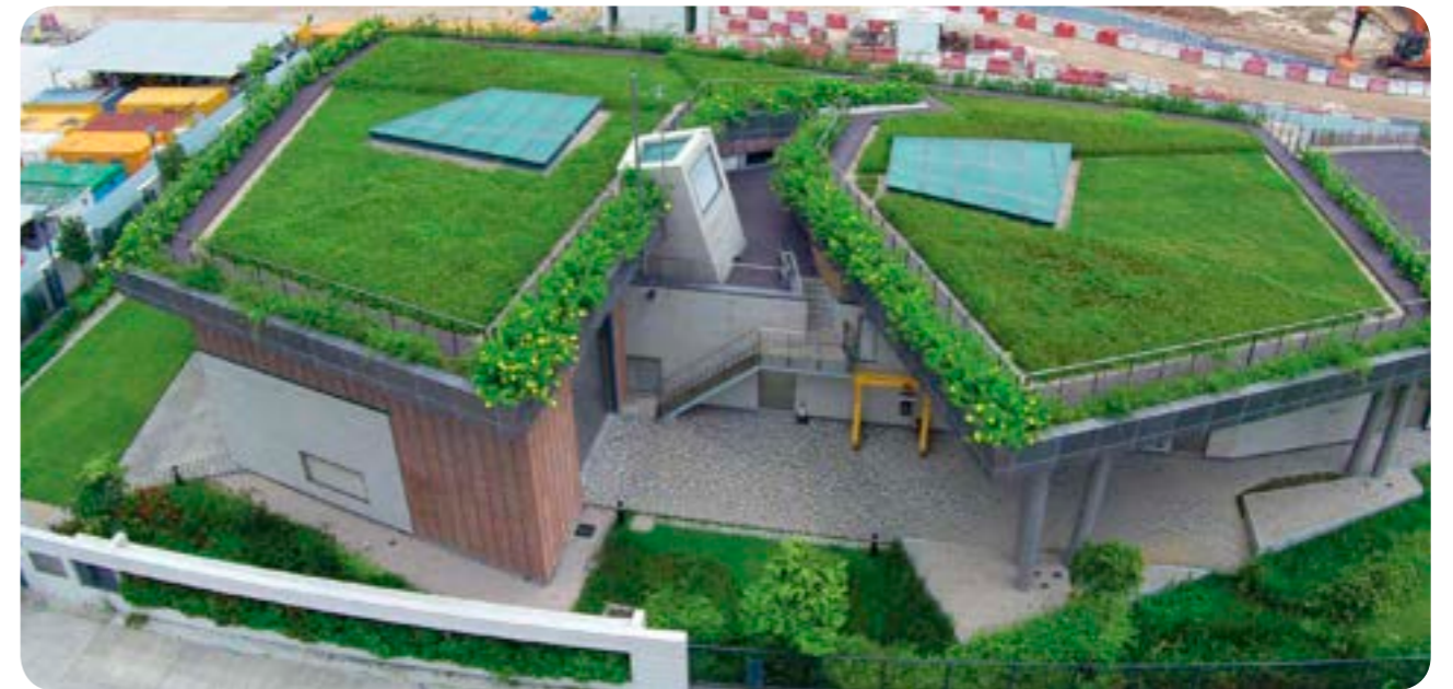
在九龍城一號及二號污水泵房的屋頂綠化 資料來源：水務署
