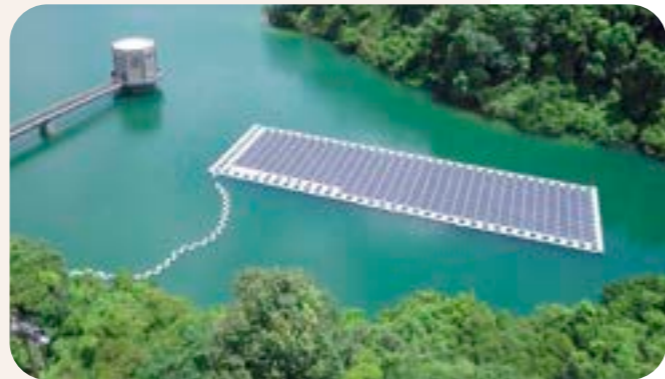
石壁水塘的浮動太陽能發電系統 資料來源：水務署
