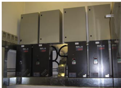
相片說明：左—直接數字控制器；中—可變速驅動器；右—冷卻水泵組 Photo caption: Left - DDC controller; Middle - VSDs; Right - Condensing water pumps
