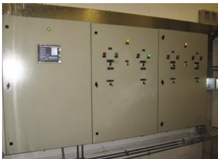
相片說明：左—直接數字控制器；中—可變速驅動器；右—冷卻水泵組 Photo caption: Left - DDC controller; Middle - VSDs; Right - Condensing water pumps
