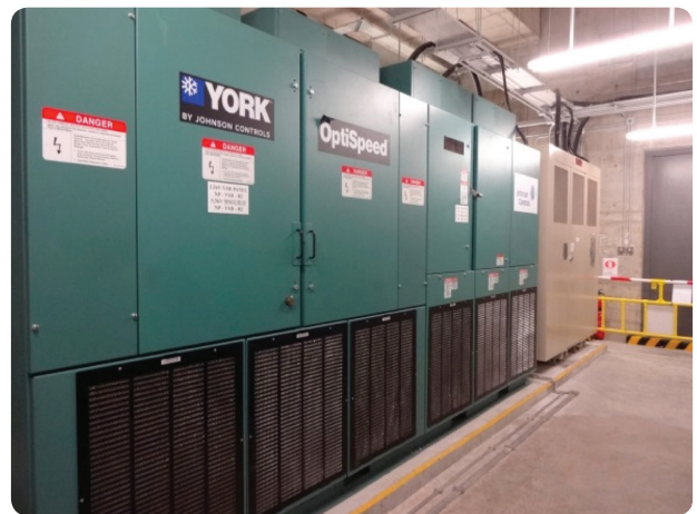
3,300伏特的變頻式馬達起動裝置與降壓變壓器 3.3kV VSD Panel with Step-down Transformer
