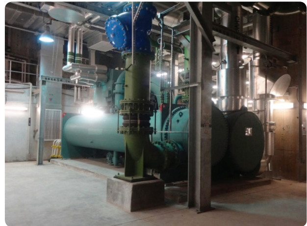
2,500冷噸製冷機組 2,500RT Chillers
