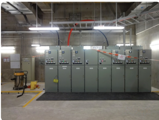
630安培真空斷路器 630A Vacuum Circuit Breaker
