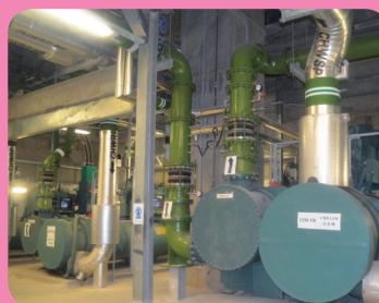
不同製冷量的製冷機組令區域供冷系統更可靠及更具能源效益
