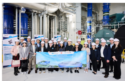
專家和代表參觀啟德區域供冷系統三號廠房
