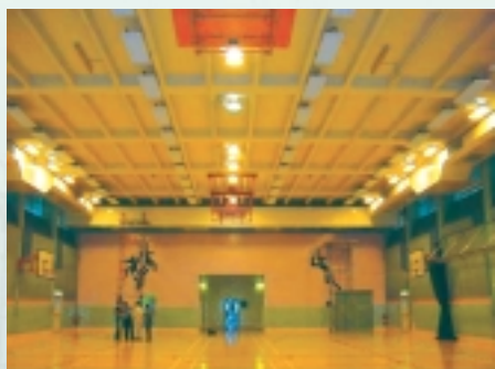
圖 1：高強度放電燈照明系統 Fig. 1: Lighting system using high-intensity discharge lamps
