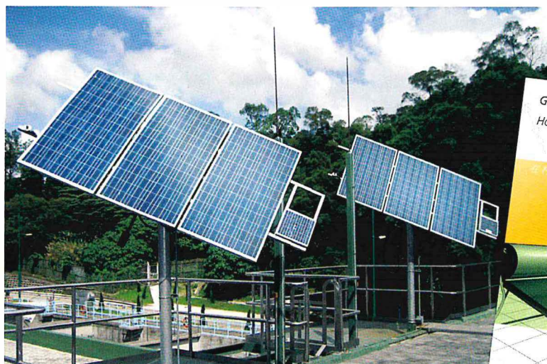
能追蹤太陽的太陽能光伏系統，可盡量吸收太陽能。
