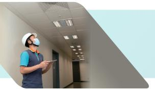
我們為公共衞生檢測中心安裝智能照明系統,利用「ZigBee」技術無線控制電力供應及記錄用電量。當該系統透過紅外線傳感器偵測到有人經過時,便會自動把燈光調節至適當光度,以節省用電。
