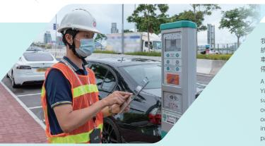
我們為運輸署在中環耀星街安裝了新一代停車收費錶,該系統除了支援不同電子支付工具外,亦配備車位傳感器,偵測車位是否已被佔用,以提供實時信息,協助駕駛者尋找空置停車位,更可配合流動應用程式「入錶易」遙距繳付泊車費。
