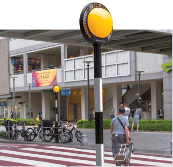
機電署自2025年第一季起開始為運輸署更換俗稱「黃波燈」（又稱「卑利沙燈」）的舊式斑馬線燈，提升道路安全意識。新燈標會發出黃色閃光光環，而燈柱會發出白色閃光，以提醒駕駛者禮讓斑馬線上的行人。
