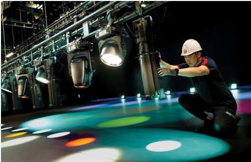
(左)西灣河文娛中心正進行翻新及改善工程至2025年6月。是次工程為劇院引入自動化吊杆系統，並首次在港島區中小型表演場地採用發光二極管舞台燈及追光燈，可大大減少高達80%的耗電量。
