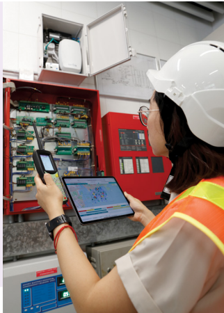
機電署在公共屋邨安裝「政府物聯網」基站和傳感器，以監察各項設施和機電設備。系統把水浸、回收箱容量、違例泊車等多項參數數碼化，實現實時監察，便利屋邨管理。
