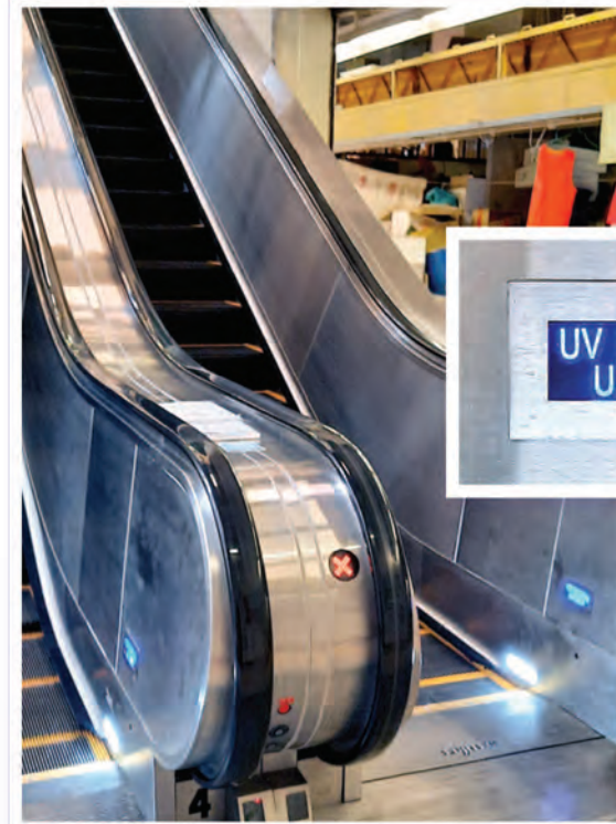
安裝在自動梯上的紫外線消毒裝置 UV disinfection devices installed on escalators
