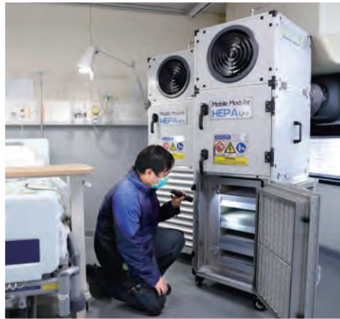
流動組合式 - 高效能 空氣微粒子過濾器 Mobile Modular High Efficiency Particulate Air Filter Units
