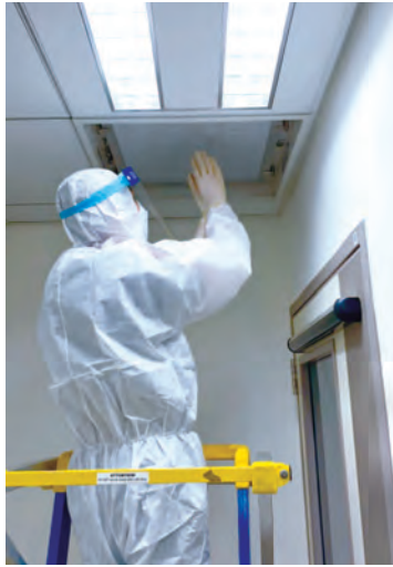
更換醫院的 空氣過濾網。 Replacing air filters in a hospital.
