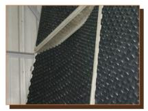
Deformed drift eliminator 已變形的收水器
