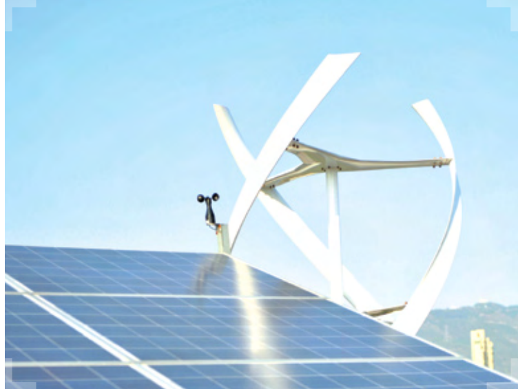
九龍醫院的風力發電機與太陽能光伏板組成混合式發電系統，是本港醫院首個同類型裝置。
