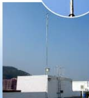
位於政府物料管理中心的風力監測站 The wind monitoring station at Government Logistics Centre
