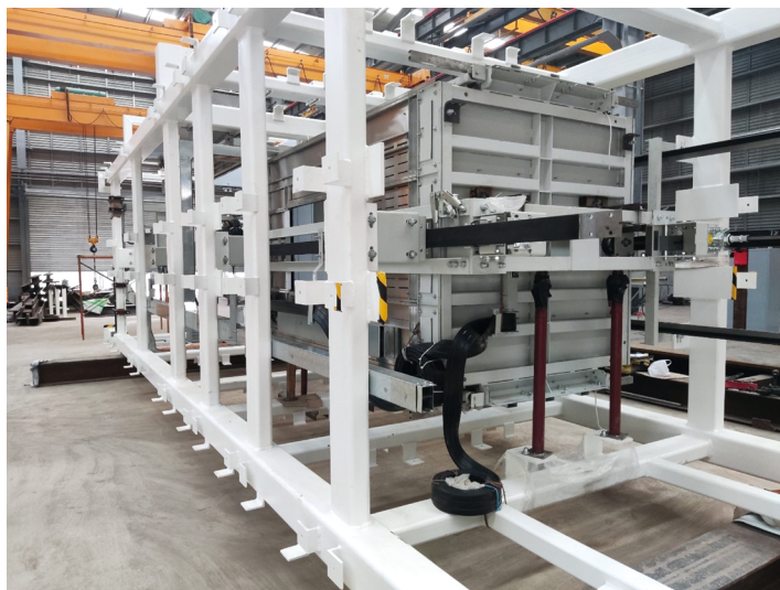
機廂預裝於井道結構支架
