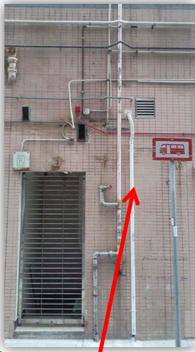
大廈外牆 垂直立管
