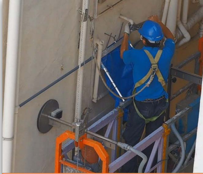
新方法：以附有真空吸盤的吊船更換立管
