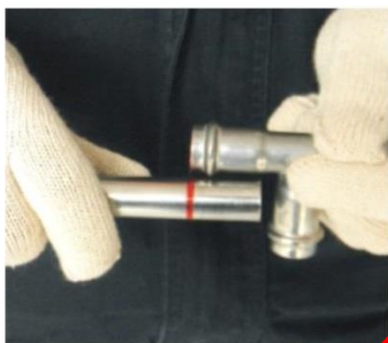
第五步: 管材插入管件
