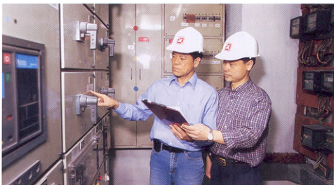
機電工程署每年進行約9,000次電力裝置實地視察
