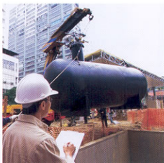
機電工程署負責監管石油氣加氣站的安全及審批
