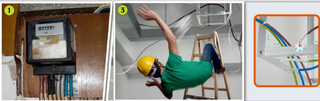
個案五 電工鋪設電線時觸及帶電金屬架
