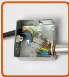
個案十 工人安裝射燈牌時觸電
