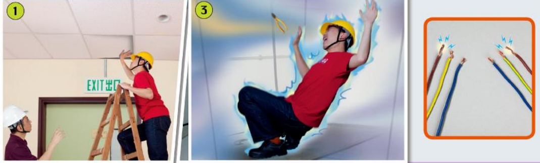
個案一 工人維修出路燈牌時觸電
