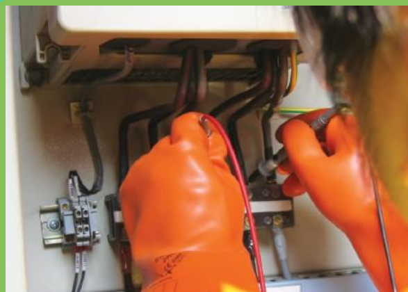
圖 2：員工使用測試設備來驗證機器的能源（電源）是否被完全切斷或消除。
