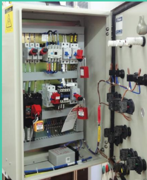
圖 1：機器設備的能源必須切斷並上鎖。
