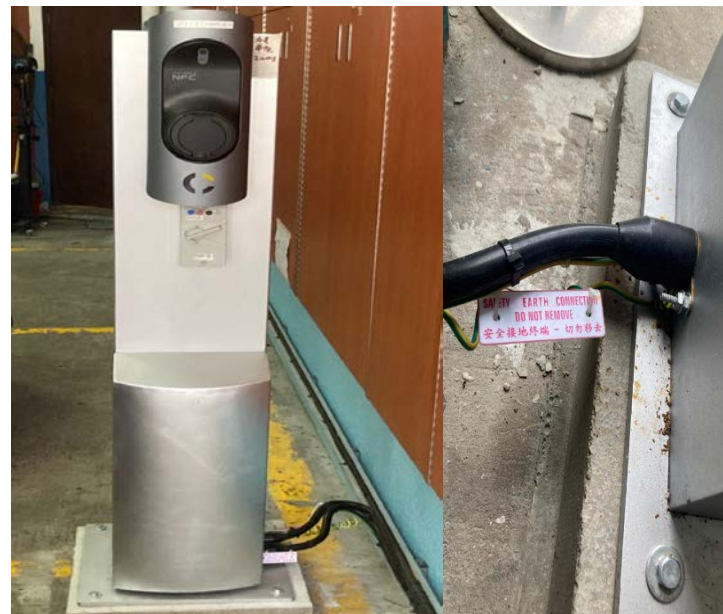
裝甲電纜須使用適當電纜封套妥善地終接於金屬包殼或線槽。
