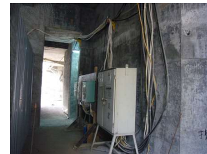
為建築或拆卸地盤、或維修及測試而提供的臨時供電裝置
