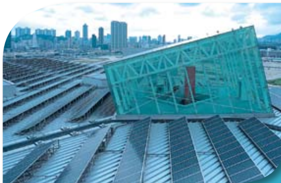
機電工程署總部大樓的太陽能光伏系統
