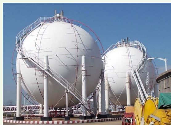
青衣石油氣儲藏庫
