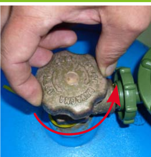
8. 以逆時針方向開啟石油氣瓶的瓶閥，並即時用肥皂水塗於瓶閥與調壓器之間的駁口，若接駁正確，接駁口該沒有氣泡；
