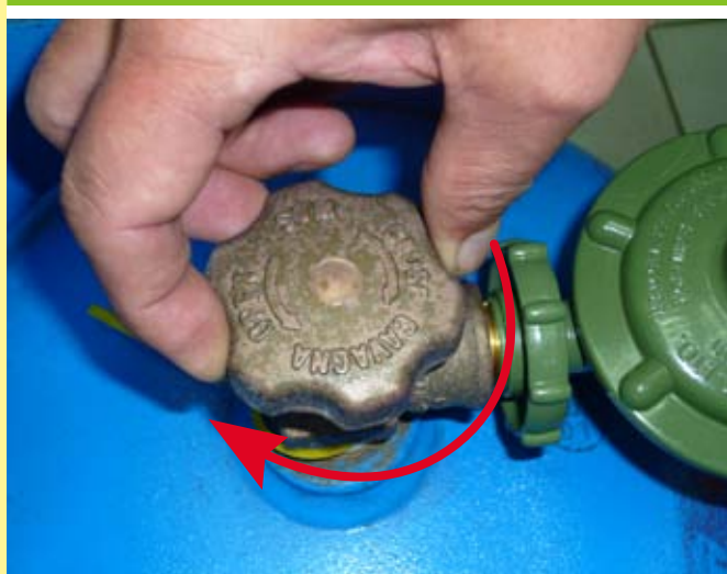
1. 緊閉石油氣瓶的瓶閥（順時針方向收緊）；
