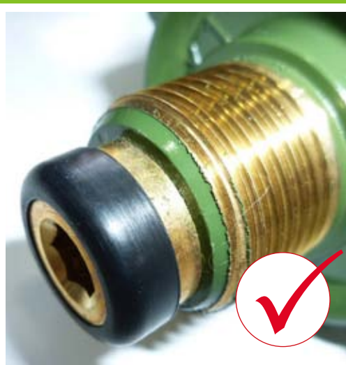
3. 檢查調壓器上的防漏膠圈有否爆裂或損毀；
