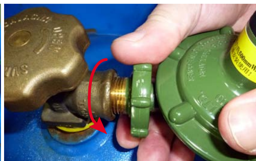
6. 將調壓器重新裝回到石油氣瓶上，此時應該一手抓緊調壓器，另一手將調壓器的手輪向逆時針方向扭入瓶閥，直至收緊為止（不可使用任何手工具借助）；
