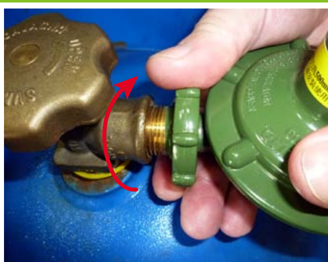
2. 一手抓緊調壓器，另一手將調壓器的手輪（俗稱唐環），向順時針方向轉動，以鬆脫調壓器；
