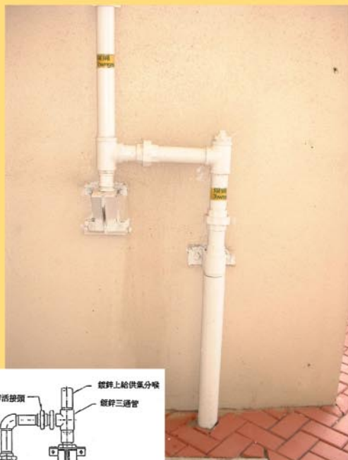
強化玻璃纖維聚乙烯立管的安裝
