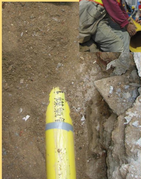
聚乙烯煤氣喉管的鋪設
