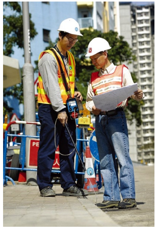
圖一 使用中的「火焰電離檢測器」
