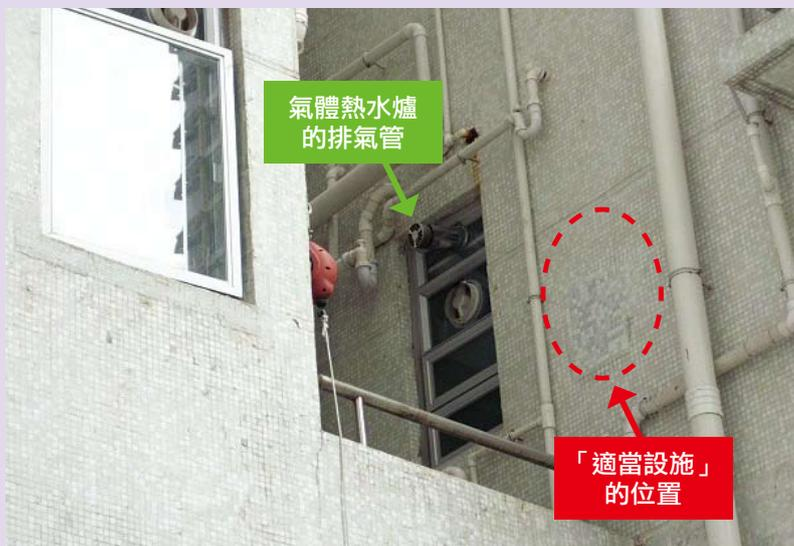
各方面的設計，符合相關條例、規則和指引的要求。擅自更改氣體熱水爐的排氣孔安裝位置，不但可能違反法例，氣體熱水爐的廢氣亦有機會直接回流屋內或其他房產內，對市民及財產構成危險。因此，業界於安裝氣體熱水爐時，須遵守上述規例，以確保氣體安全。🔥
