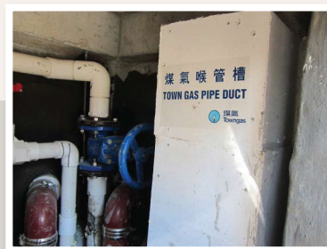
圖二：煤氣喉管槽
