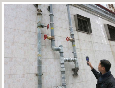
圖三：檢測供氣分喉管
