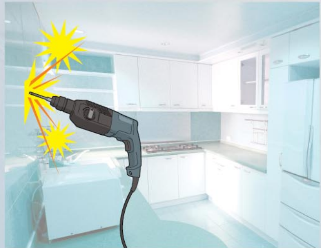
■ 進行家居裝修時，小心破壞牆內暗藏的氣體喉管
