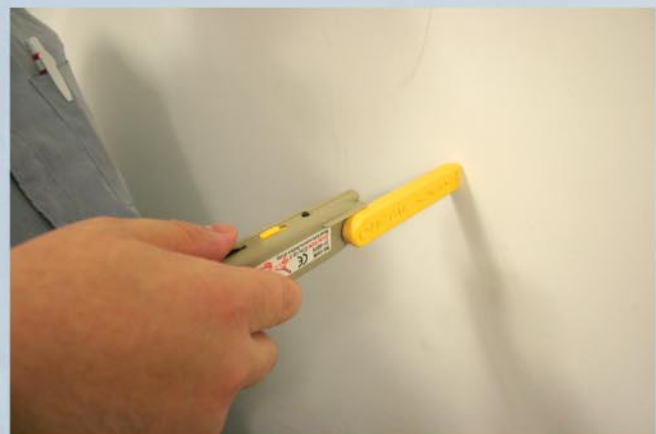
■ 在施工前，利用金屬探測器探測牆內喉管的確實位置
