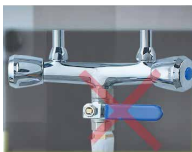
切勿在「花灑儲水式」電熱水爐安裝設有開關水掣的花灑頭
