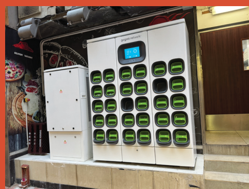
充电系统每次最多可为30个电池充电。
